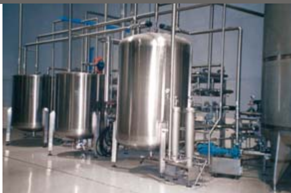
Impianto lavorazione succo di dattero Dates juice producing plant
